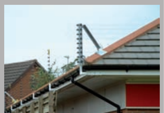
Montage de toiture
