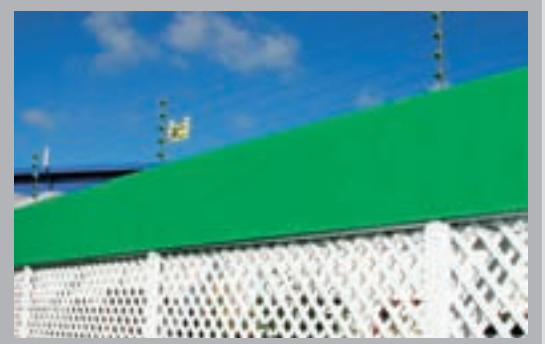
Montaggio sul muro
