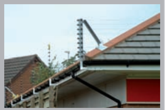
Montaggio sul tetto
