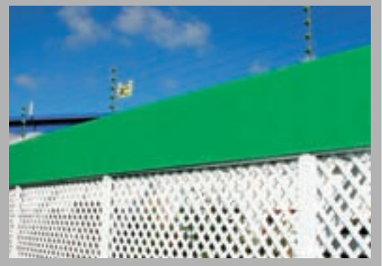
Montagem no muro
