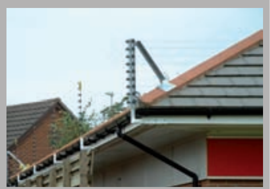
Montagem na telha
