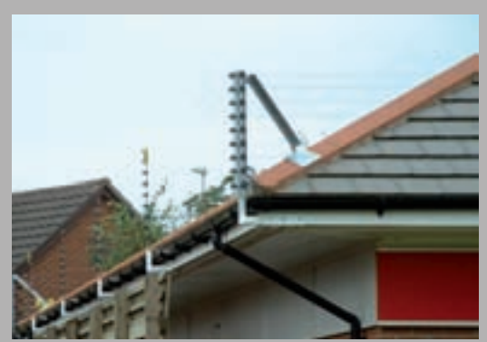
Instalación en el techo
