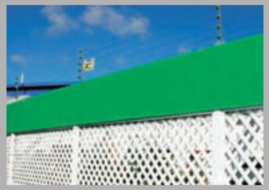
Instalación en el muro
